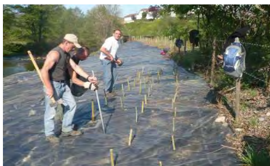
Figure 23 : Site après pose de la bâche [41]
