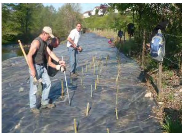
Figure 24 : Installation des 2400 boutures de saules [41]
