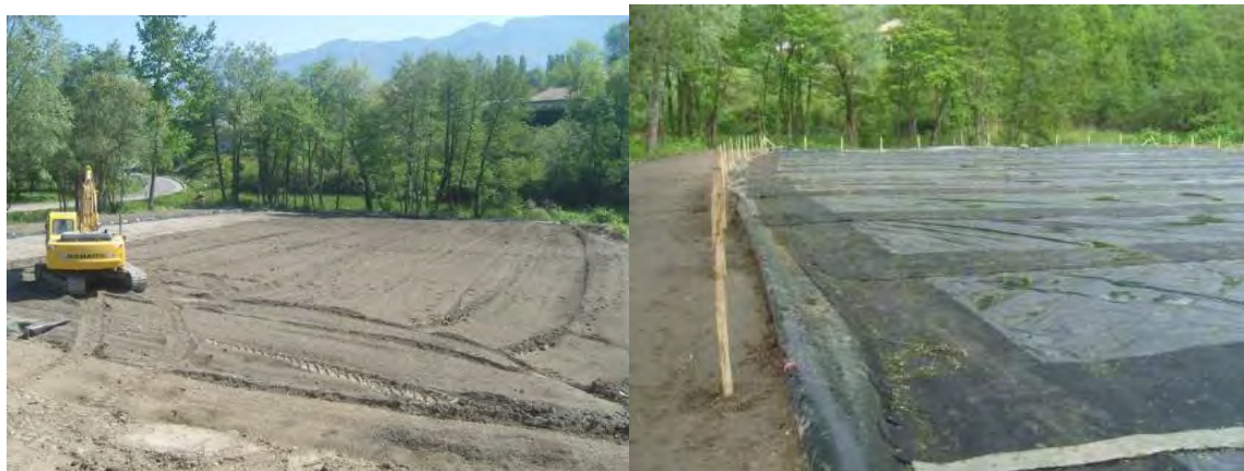
Figure 14 : Concassage bâchage à Viviers-du-Lac [10]
