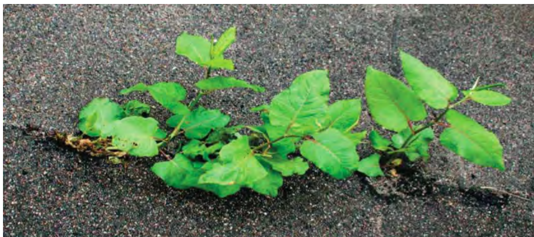
Figure 6 : Une Renouée passant à travers le bitume
