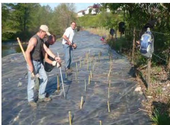
Figure 24 : Installation des 2400 boutures de saules [41]
